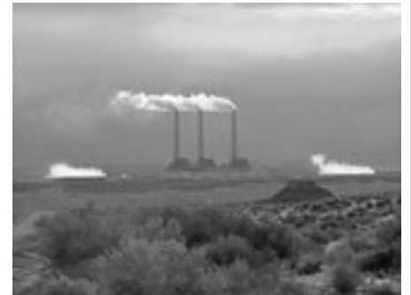
Navajo generating station, Arizona. Courtesy of Dr. Martin Pasqualetti.
