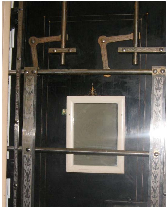
031 Vault door detail
