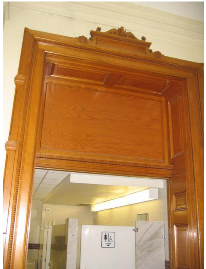
021 Original vestibule door casing
