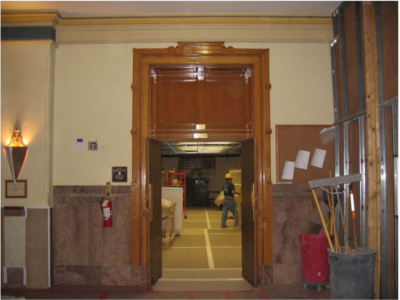
0124 Entry door to Hallway 0110
