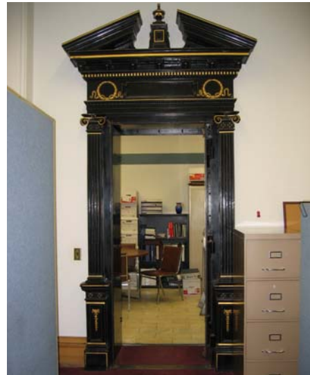
121B Ornate vault door frame.
