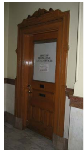
054 Entry door Arcade side
