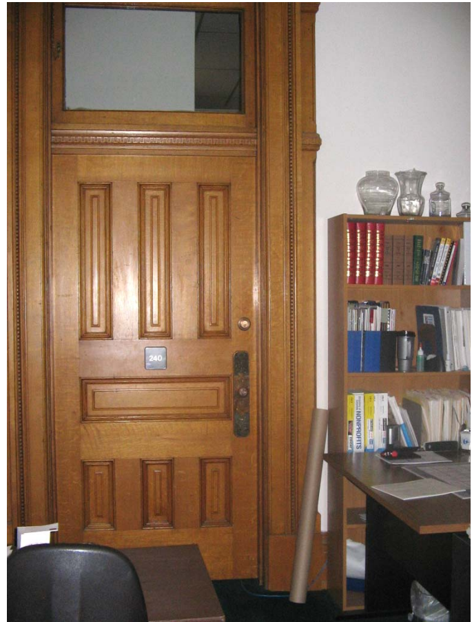
239 Door to Room 240
