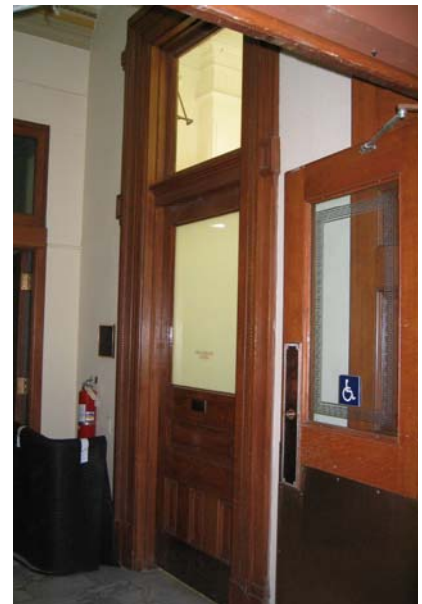
078 entry door Arcade side
