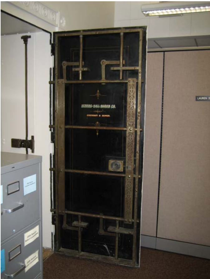
045 Vault door to 045A
