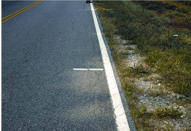
Figure 10 - Edge Cracking
