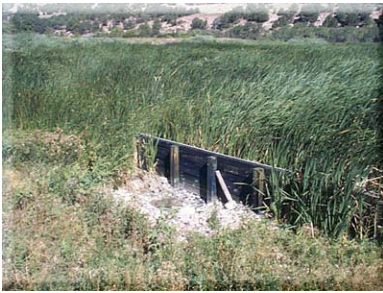
Effluent end of wetland cell
