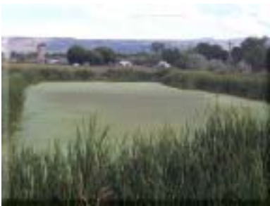
Sunken wetland cell
